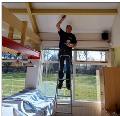
Er wordt goed gewerkt in de Vaandrig....
